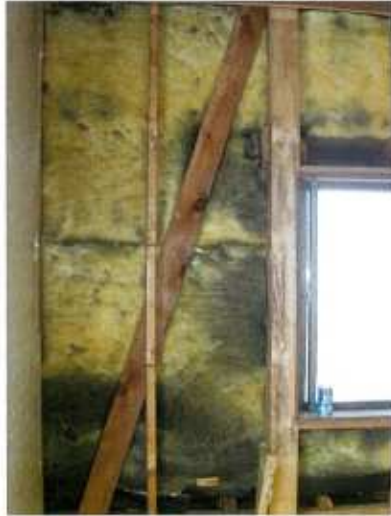
結露によりカビが生え劣化した壁内
