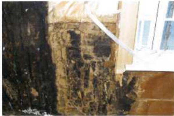
結露によりカビが生え劣化した壁内
